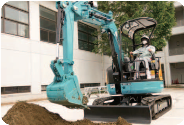
パワーショベルの操作
