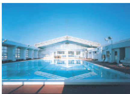
屋根開閉型プール
