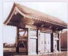
昭和 25年 現在地に落成した正門
