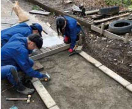
総合実習：園路施工
